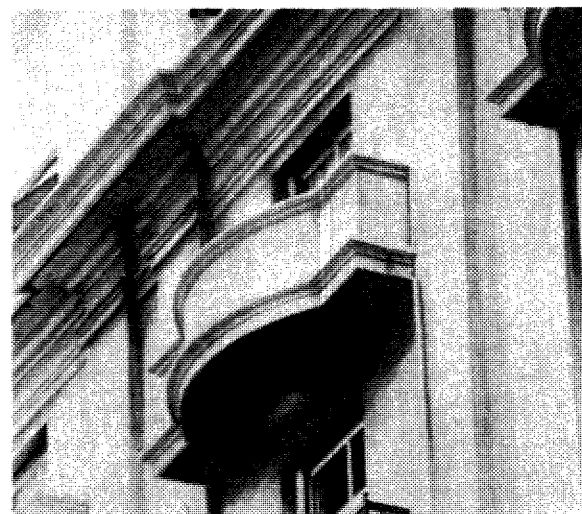
Balcones en los tres primeros locales: calle Cuareim, calle Colonia y, abajo, calle San José. Tres etapas cumplidas.
